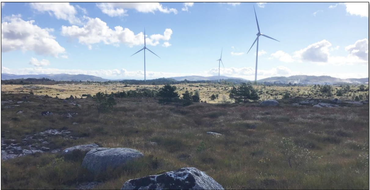
Figur 4-4. Kystlyngheilandskapet med vindkraftverk ved Gismarvik sørøst for ny transformatorstasjon. Man kan se deler av Haugalandet næringspark i bakgrunnen. Området har og kommer til å ha betydelig med industri i fremtiden.
